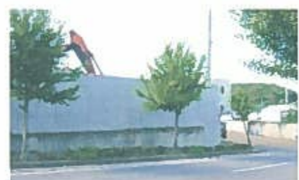
高3m x 長60mコンクリート製飛散防止壁
