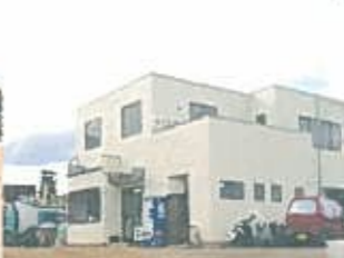
本社事業所(管理棟) 60tonデジタル計量システム
